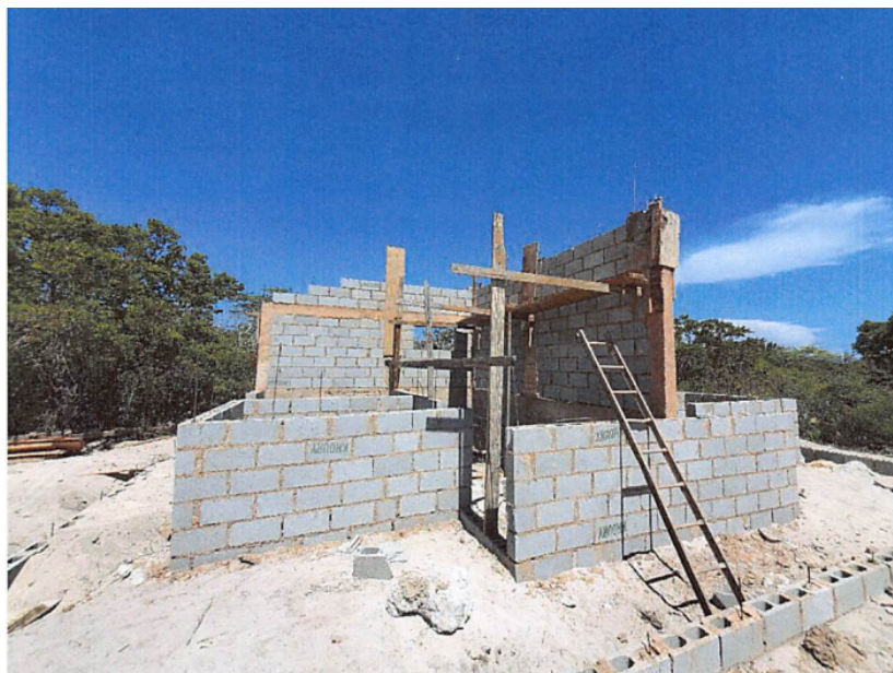
Ilustración 14. Inicio del proceso de construcción de los baños de visitantes en la playa de Bahía de las Águilas, provincia Pedernales, República Dominicana, agosto 2022
